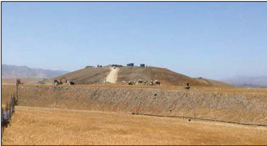
Vista hacia el oeste hacia la porción sur del área de Clase I mostrando área elevada desde la colocación del suelo
