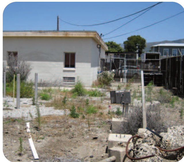
Antigua subestación de la zona
