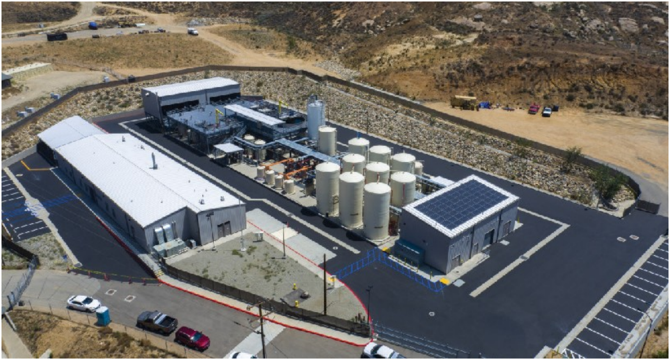
La Nueva Instalación de Tratamiento de Pyrite Canyon (PCTF) ya completada.
