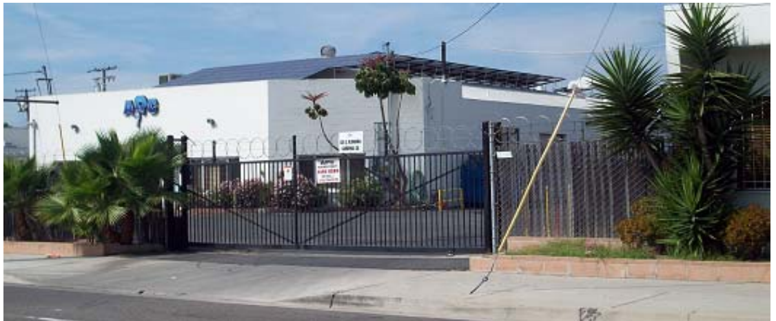
. Entrada a la Instalacion desde East Alondra Blvd.
