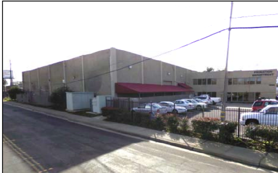
Vista de la instalación desde West Fremont Street
